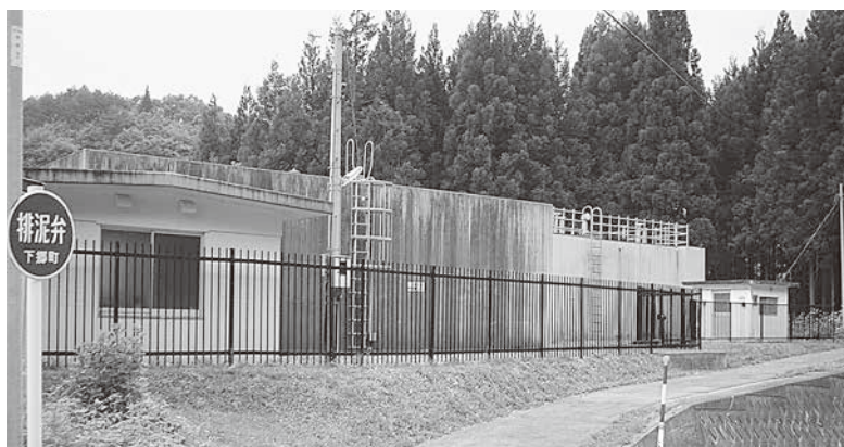
湯野上配水池
